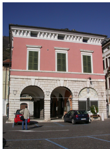
Foto 2 Facciata fronte lago con il portico e le catene al piano terra
