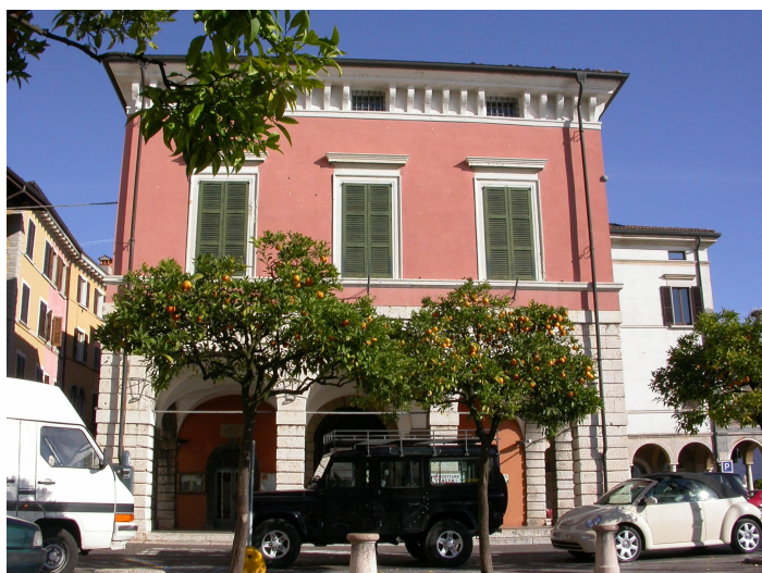
Foto 1 Vista della facciata principale con il colonnato a piano terra, le finestre della sala polifunzionale al piano primo e delle finestre del sottotetto
